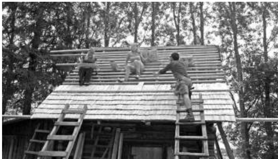
Радионица: изградња дрвеної крова. Фойџо: Е. Лутсейџ, 2008. Workshop of building of wooden roof. Photo: E. Lutsepp, 2008.
